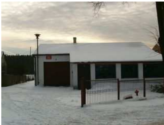
Fot. 6 . Budynek remizy strażackiej w Sorbinie
