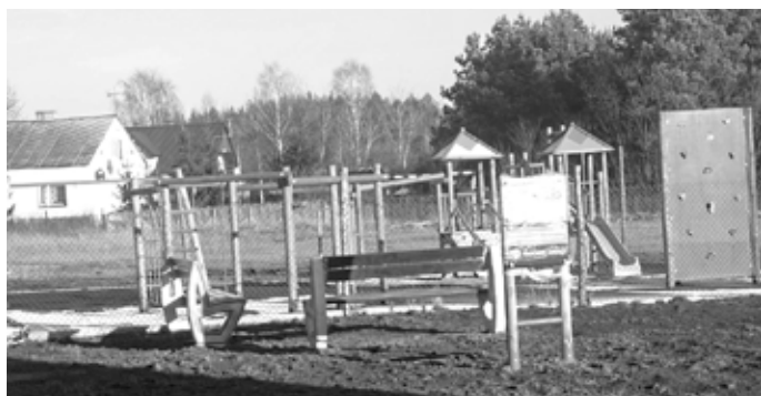
Plac zabaw w Mroczkowie w budowie z programu „Radosna szkoła”
