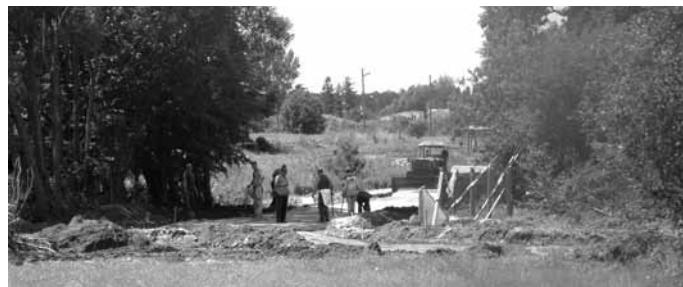
Budowa drogi w Gostkowie
