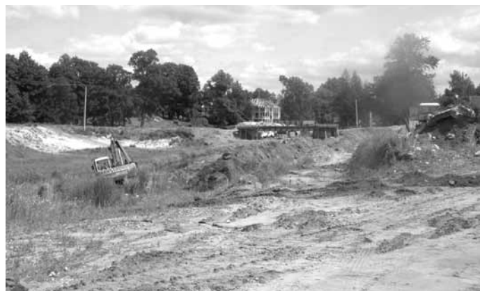
Prace ziemne przy zaporze
