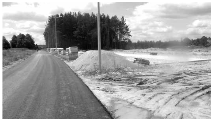
Droga jest gotowa, parking w budowie
