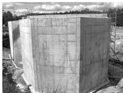
Kolektory na oczyszczalni
