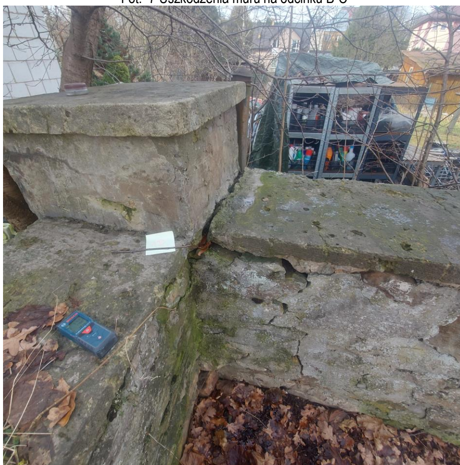
Fot. 8 Spękanie narożnika C
