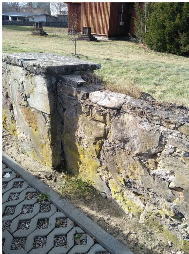
Fot. 2 Uszkodzenia muru na odcinku A-B
