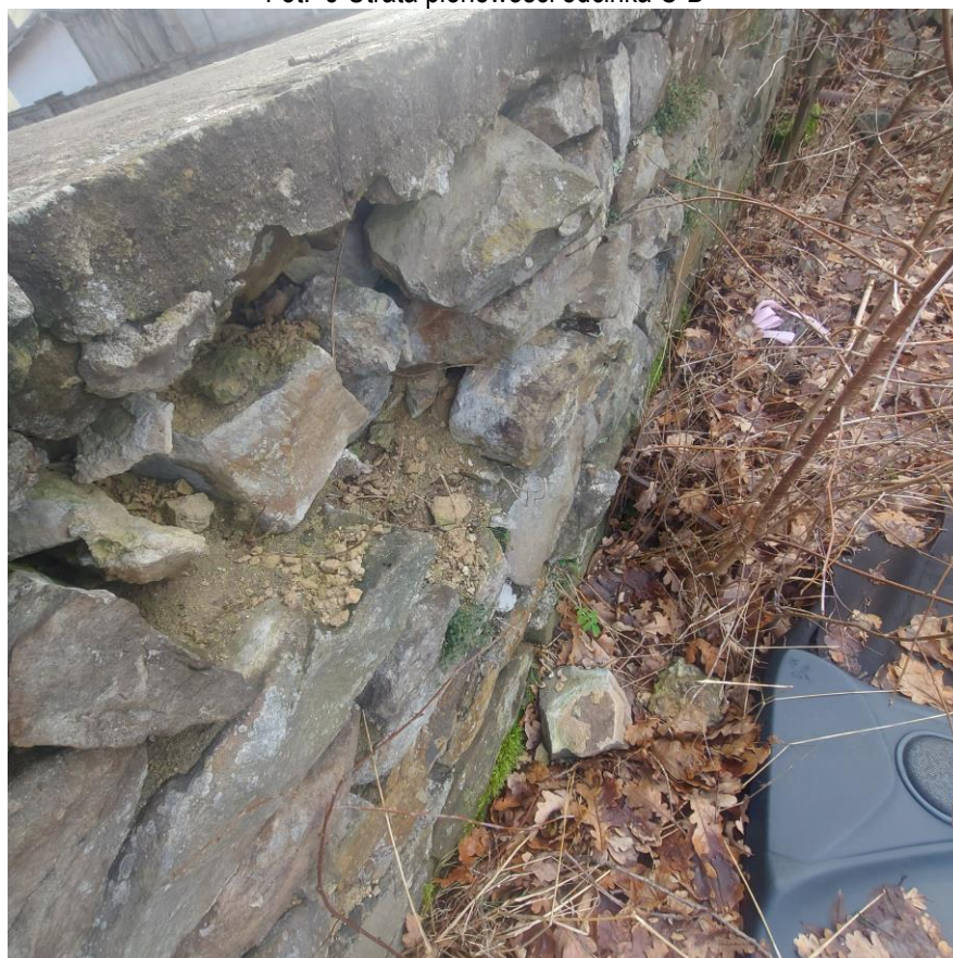
Fot. 10 Uszkodzenia muru odcinek C-D
