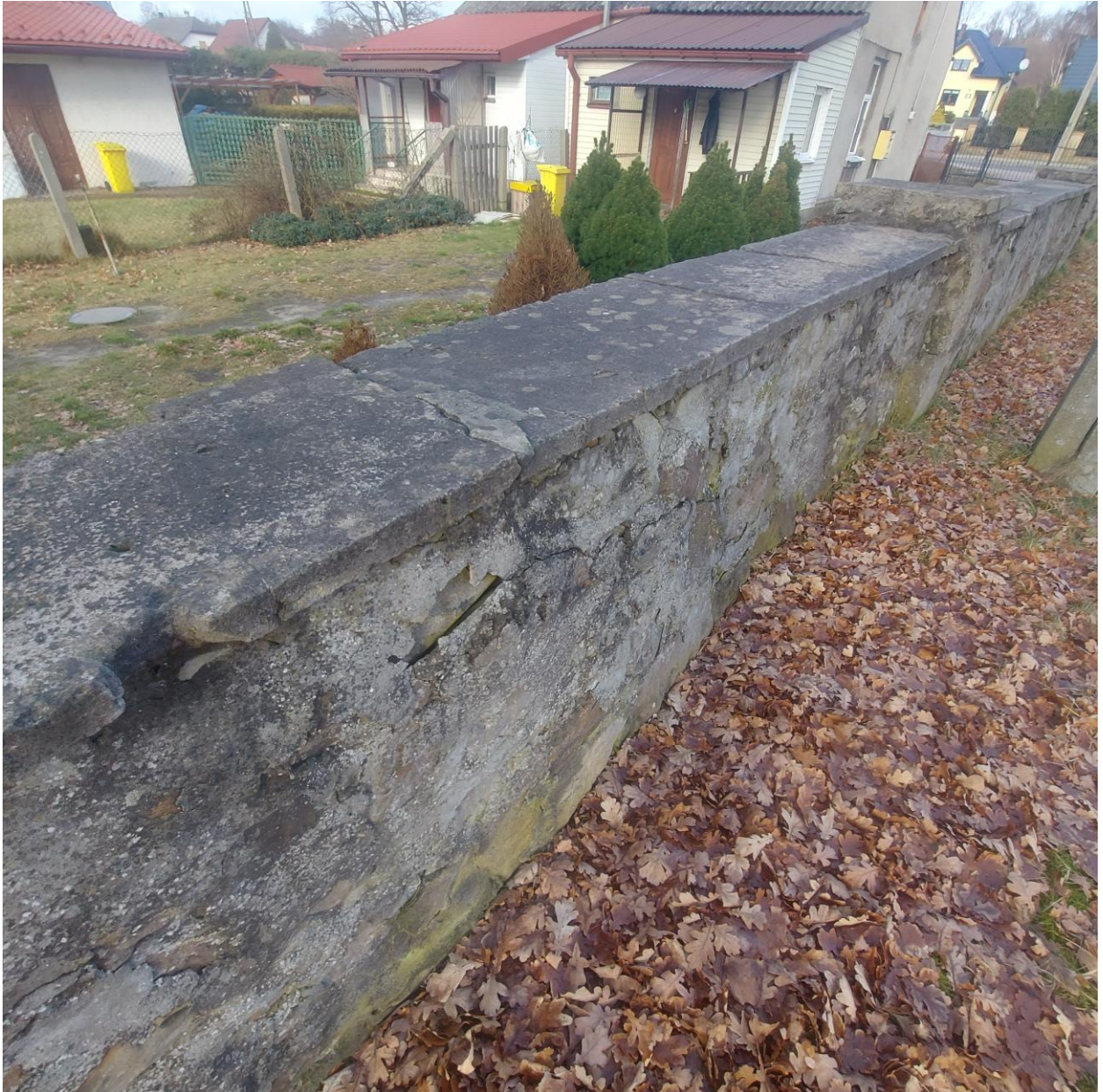
Fot. 11 Uszkodzenia muru odcinek C-D
