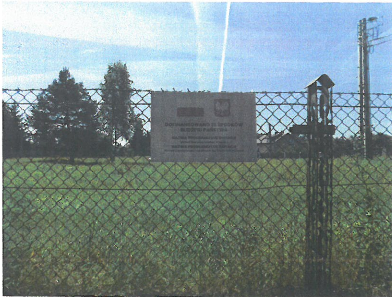
Fot. przedstawiające grodzenie metalowe z siatki ogrodzeniowej
