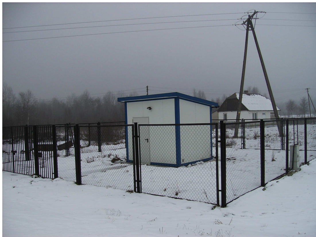
Zdjęcie nr 16. Przepompownia w przysiółku Żabów
