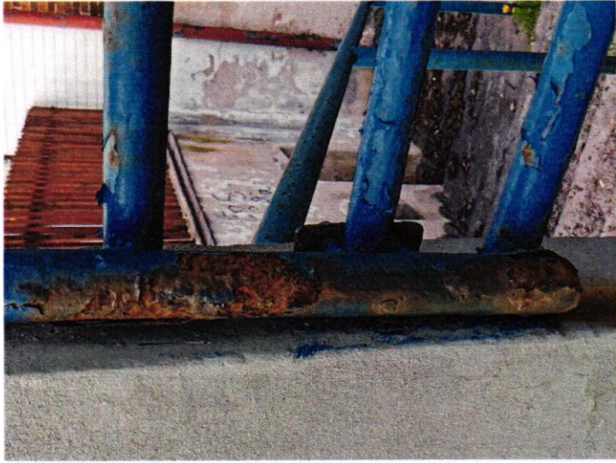
Przykładowe zdjęcia, skorodowanych elementów balustrady przepustu wodnego na DK42 w Bliżynie.
