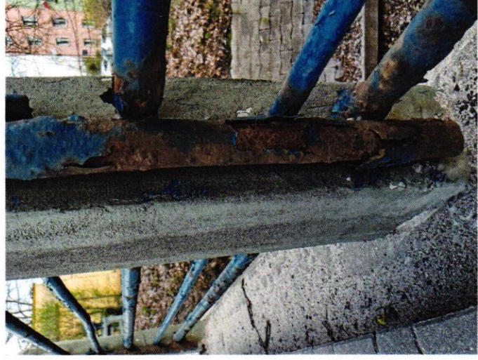
Przykładowe zdjęcia, skorodowanych elementów balustrady przepustu wodnego na DK42 w Bliżynie.
