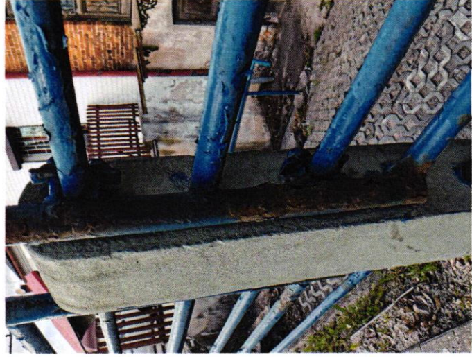
Przykładowe zdjęcia, skorodowanych elementów balustrady przepustu wodnego na DK42 w Bliżynie.
